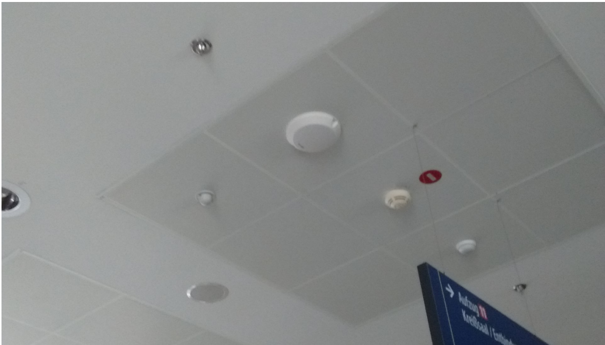
Abbildung-4 (nach Umrüstung auf Aruba ANT-40 Dualbandantenne, beachte es wurde nur eine Antenne ausgetauscht, beachte: die zweite Huber+Suhner Omni directional Antenne ist nicht mehr in Betrieb)
